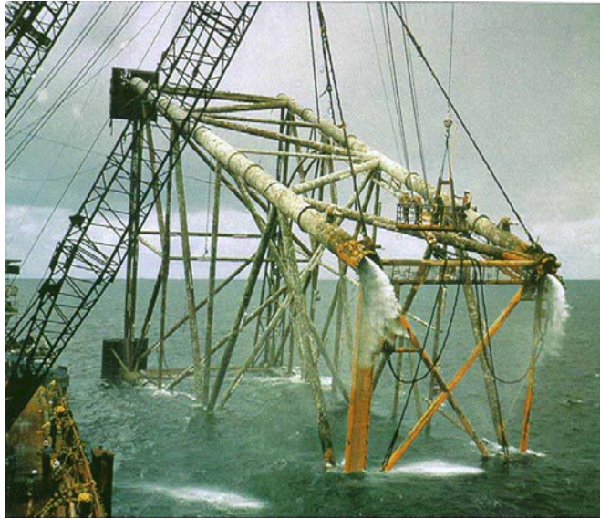
Figur 1.1.2 Fjerning av offshoreinstallasjon [2]
