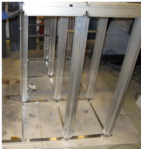
Figur 7-2 Montering av grid
