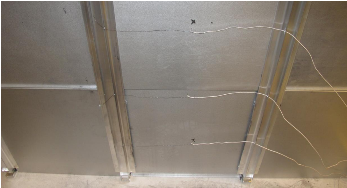
Figur 7-6 Feste av termoelementer på varm side
