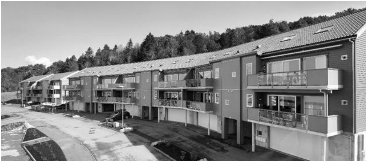
Figur 10 viser to av de fire bygningskroppene. "Oppiskar" fremst og "Utskar" bakerst i bilde. "Oppiskar" inneholder 12 leiligheter, mens "Utskar" består av 8 leiligheter.
