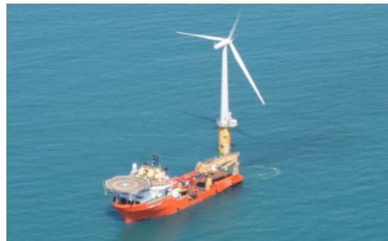
Bilde nr. 8: Solstads Normand Pioner under arbeidet med Hywind utforbi Karmøy. En avansert operasjon som krever gode rammer.
