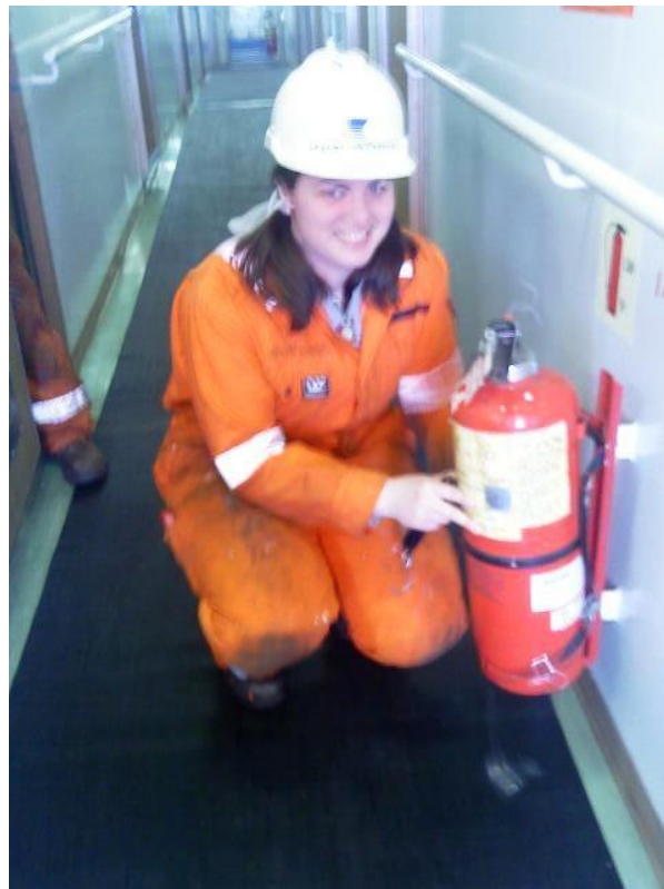
Figur 2: Årlig sjekk av brannslukkings apparat
