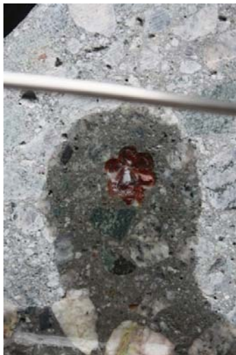
Figur 41, Boblende vann observert fra armeringen
