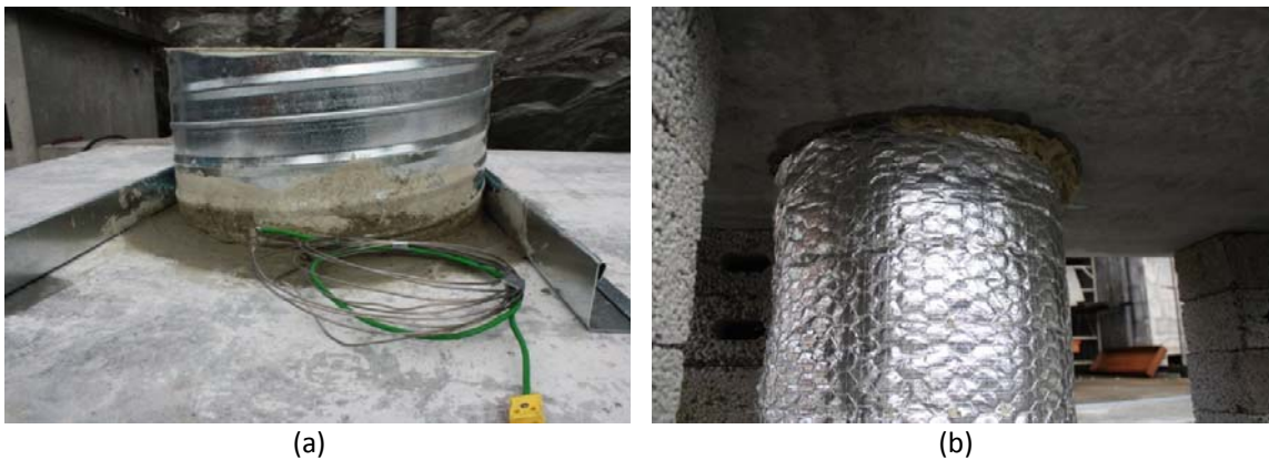
Figur 11, Ventilasjonsrøret (a) Sett ovenfra (b) Sett fra undersiden
