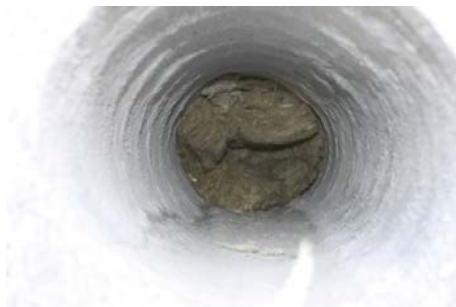
Figur 16, Rockwool i kanalene
