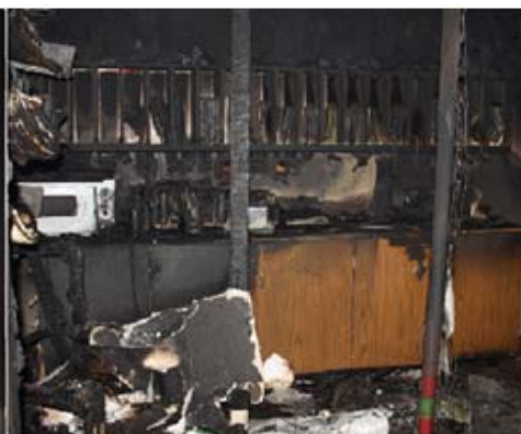
Brannrel, tatt fra ventilasjonsdel
