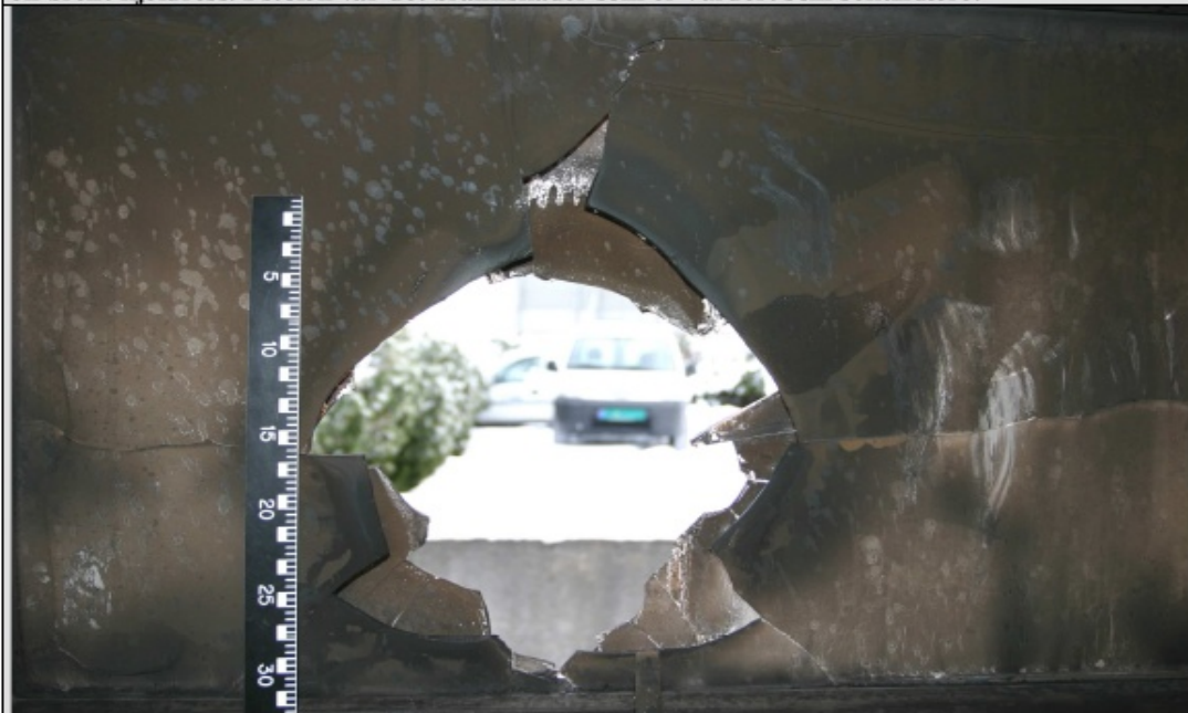
Fig. 6 Hull i vinduet ved sittegruppa sett fra innsiden.
