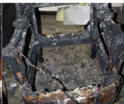
Lenestol etter utgraving, med ledning fra loddebolt
