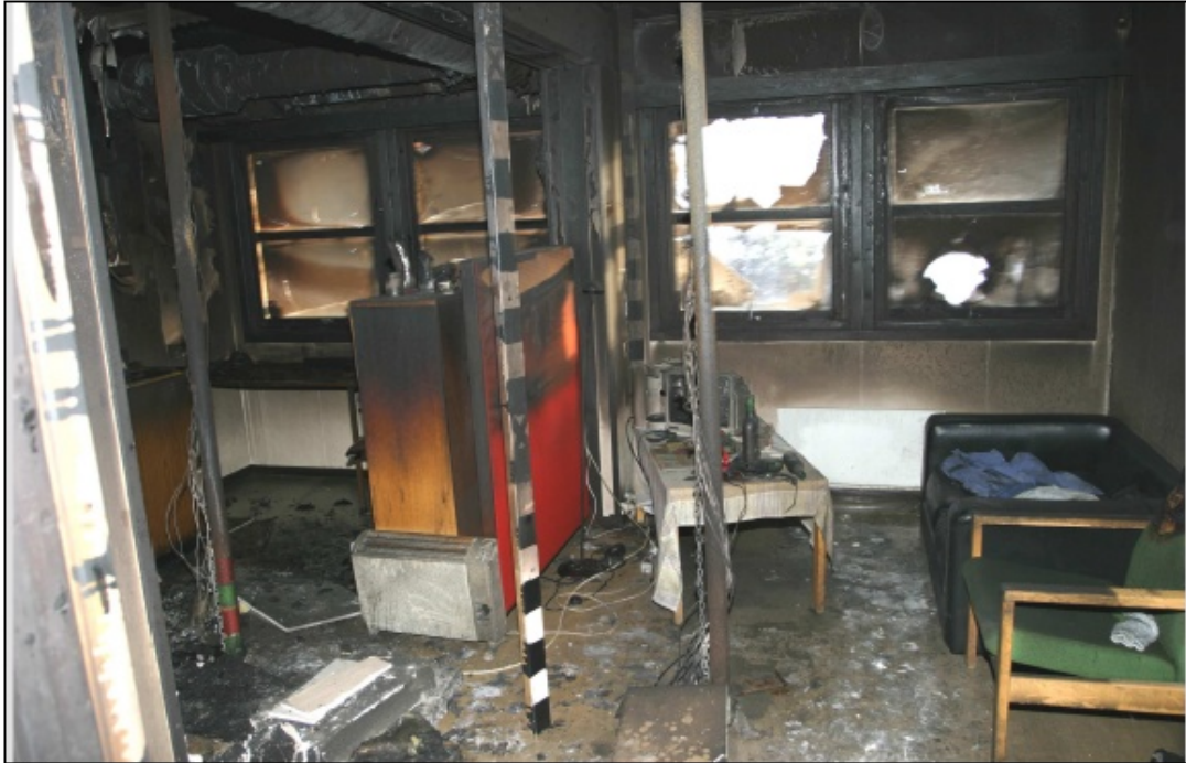
Fig. 1 Viser pauserommet sett fra døra fra gangen.
