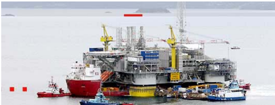
Figur 2.4 Sammenstilling av understell og dekk i fjorden utenfor Aker Stord.
