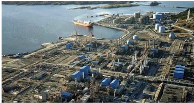
Bilde 1-1 Kårstø prosesseringsanlegg
