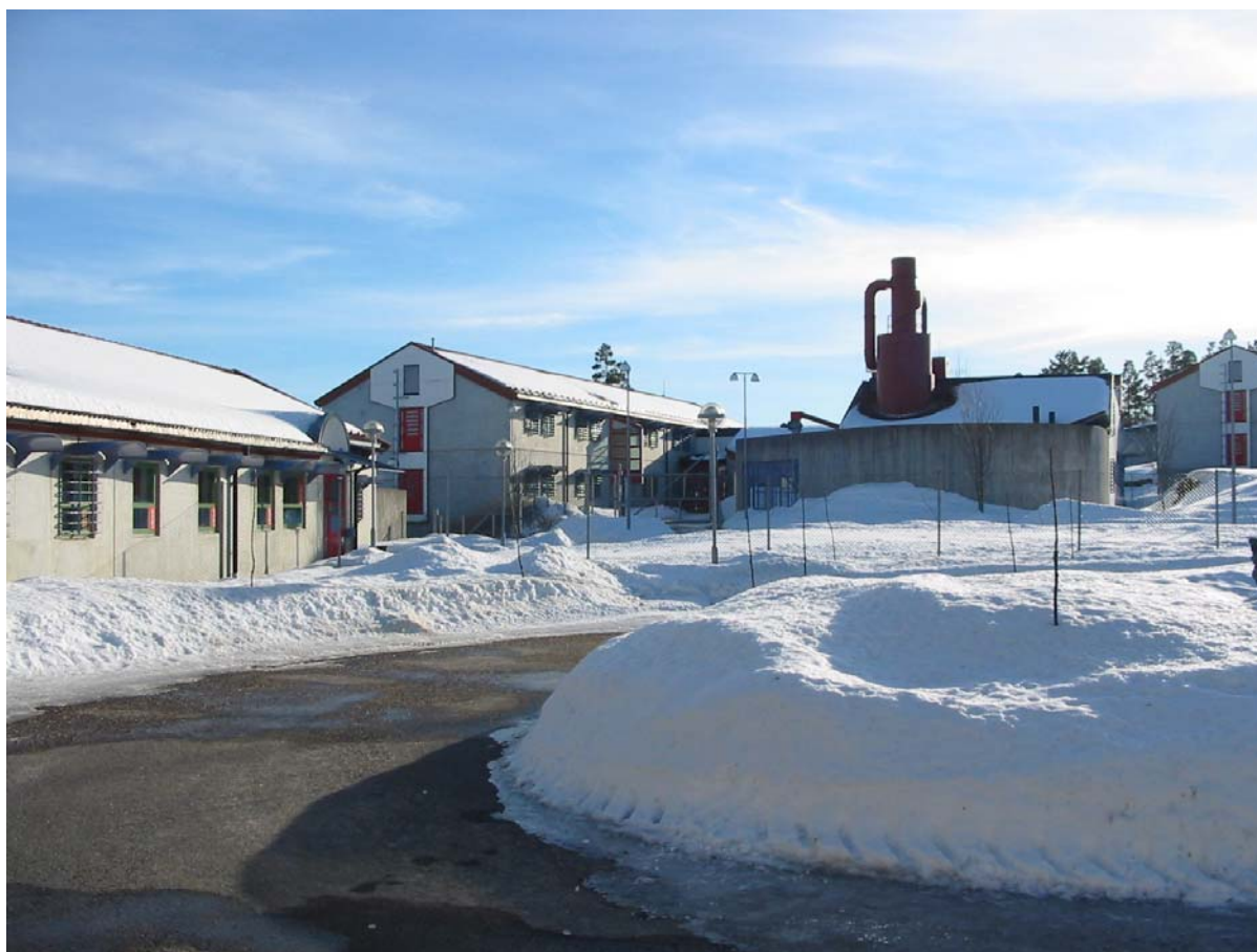
Bilde 4. Viser aktuelt analyseobjekt innad i anstalten, objektet er en avdeling med eget verksted.
