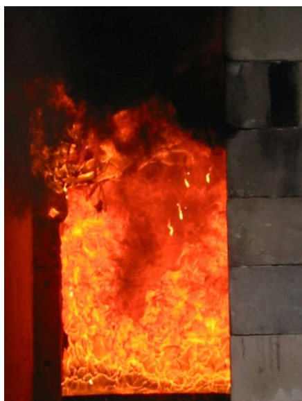
Bilde 4.16 – Kablene er dekket av flammer
