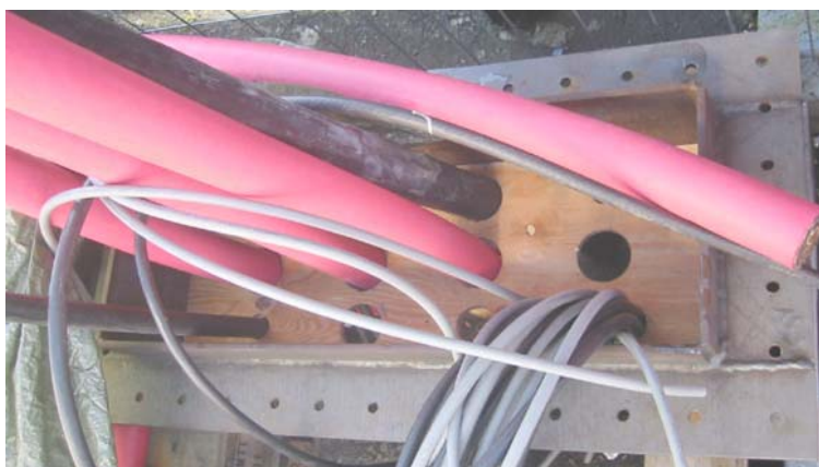
Bilde 3.2 – Forskalingen i gjennomføringene
