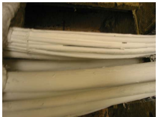
Bilde 4.13 – Kabler med brannmaling test 3
