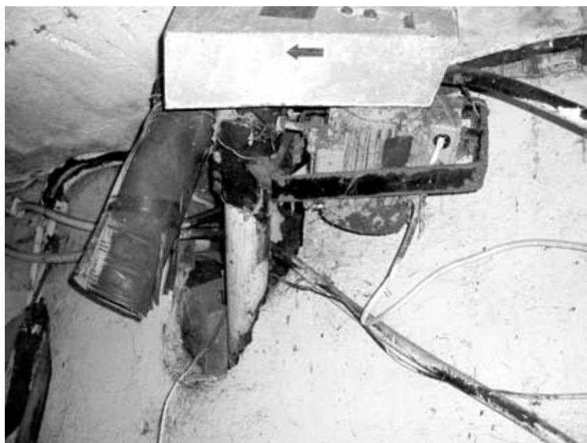
Vedleggsfigur 3 Utettet hull mellom klopphus og husdyrrom. (Foto: I-J Helland)
