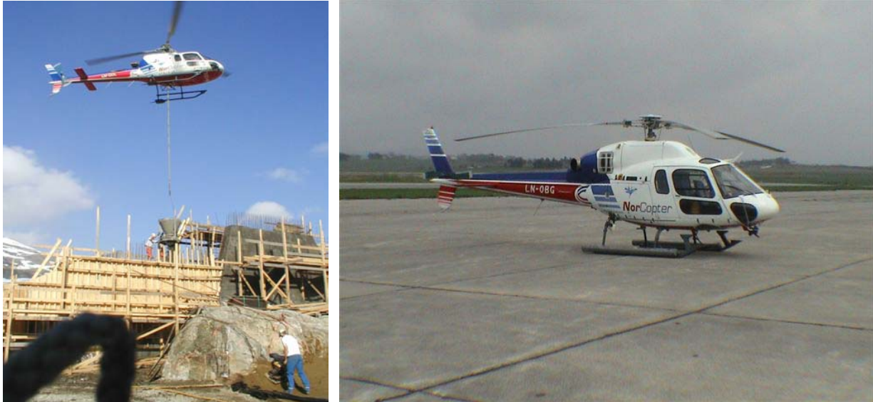
Støpe operasjon med helikopter
