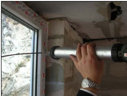
Figur 19: Påføring av branntettemiddel 1
