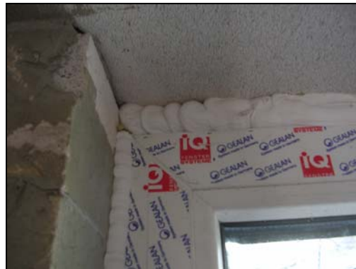
Figur 20: Påføring av branntettemiddel 2
