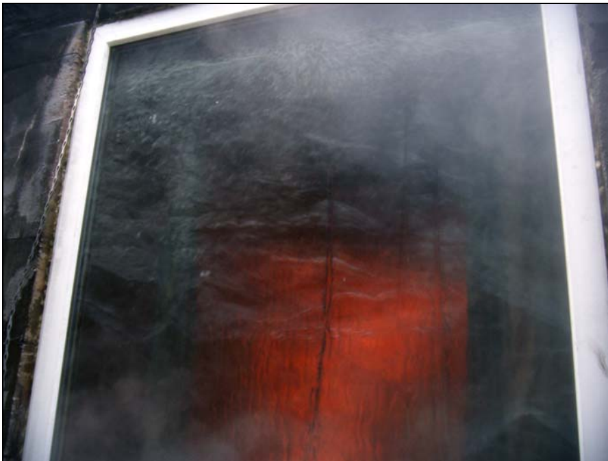
Figur 34: Vindussprinkler sett utenfra
