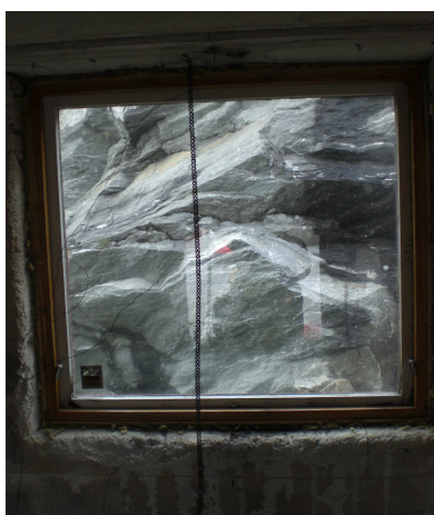
Figur 25. Montert trevindu fra innside.
