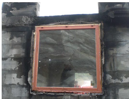
Figur 26. Montert trevindu fra utside.
