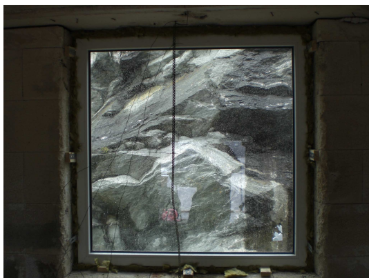
Figur 23. Montert PVC vindu fra innside.
