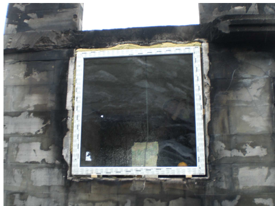
Figur 24. Montert PVC vindu fra utside.
