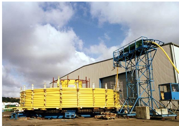
Bilde 2.5: Umbilical som holder på å bli lagt på et installeringshjul
