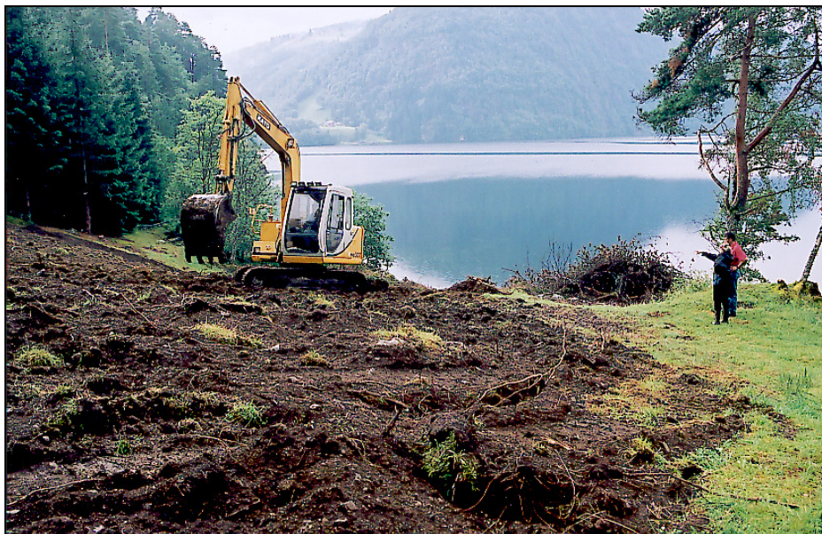
Fig. 4. Det ble fjernet flere store grantrær både på og rundt forsøksfeltet. Arbeidet ble gjennomført med traktor. Etterpå ble marka jevnet til. Foto: Brith Natlandsmyr.
