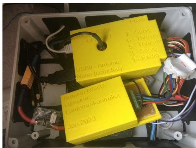
Figur 20: Bilde av utbedret koblingsboks (Privat)
