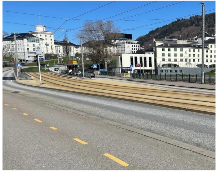
Figur 45: Florida bybanestopp, her må det etableres en ny sporskifter (foto: privat)
