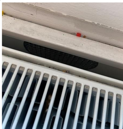
Bilde 40: Avtrekksløsning bak radiator i klasserom, privat foto
