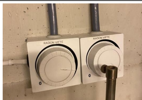
Bilde 28: Styringsmekanismer for radonvifte, lokalisert under administrasjonsdel, privat foto
