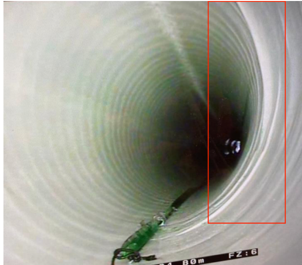
Figur 18: Folder i et DN1200 rør med 22,5 graders bend (Heggernes, 2023).
