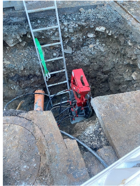
Figur 16: Tilkomstgrop til blokking av 140mm stålrør i Bjørkåsen.
