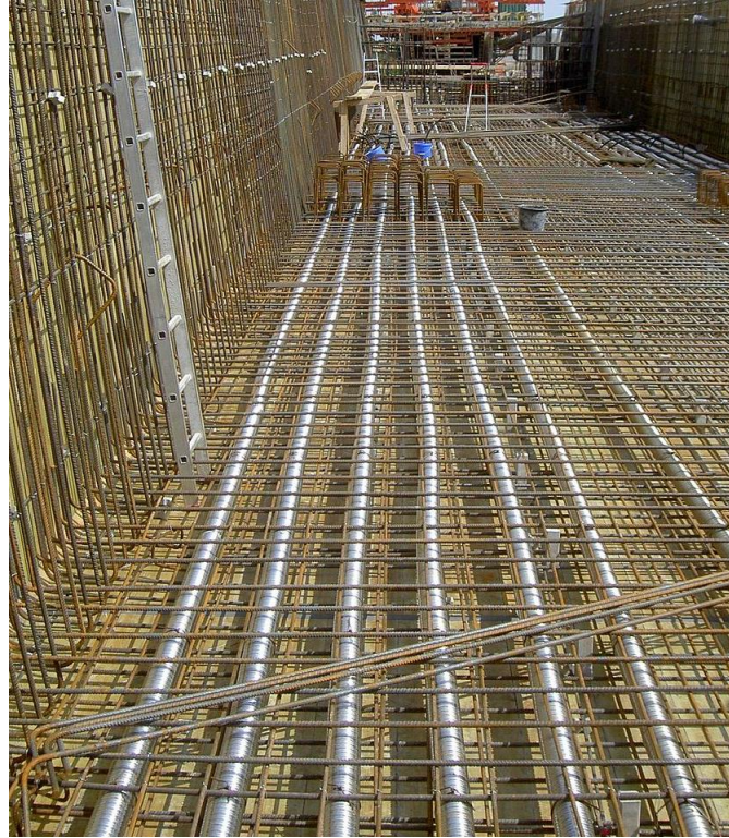
FIGUR 7. KABELRØR FOR ETTEROPSPENT ARMERING, HENTET FRA: WIKIPEDIA
