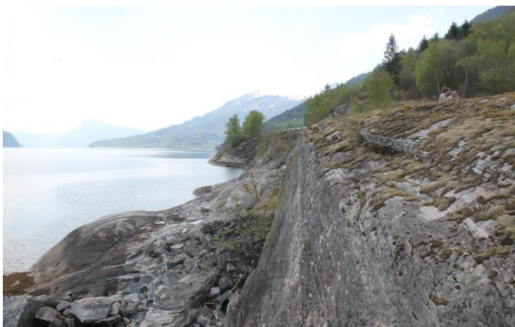
Figur 46. Bratt skrent på sørsiden av rasteplassen.
