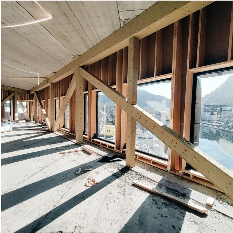
Figur 20: Brannisolert fagverk
