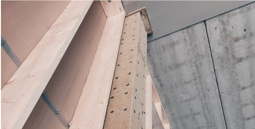
Figur 23: Brannisolering søyle
