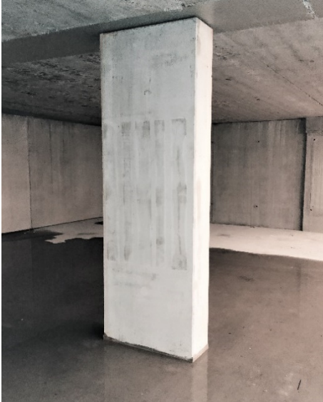
Figur 8: Betong søyle i parkeringskjeller. (Privat foto)
