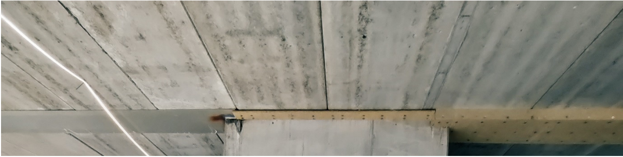
Figur 11: Hulldekke HD320 som hviler på både deltabjelke og HSQ bjelke. (Privat foto)
