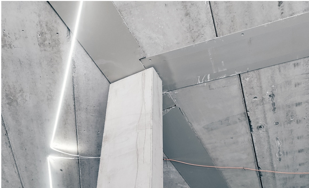
Figur 6: Knutepunkt bestående av 3 deltabjelker som hviler på en betongsøyle. (Privat foto)
