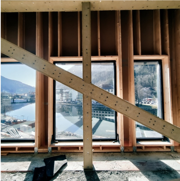
Figur 22: Vertikale Nullstaver (privat foto)
