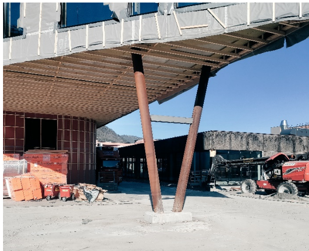
Figur 7: Stålsøyle. (Privat foto)
