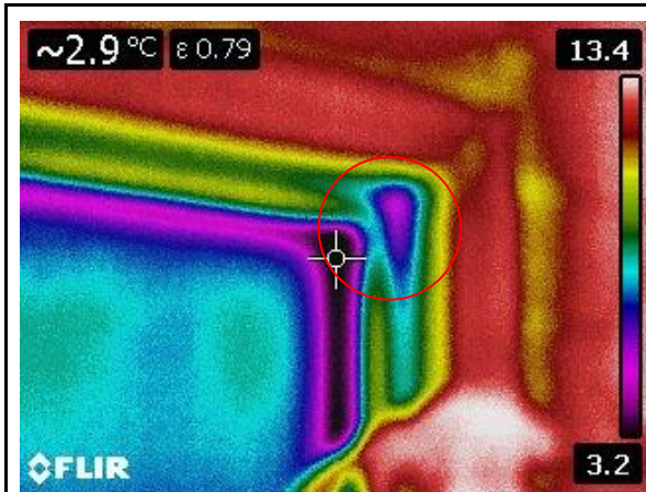
Figur 17: Termogram av vindu.
