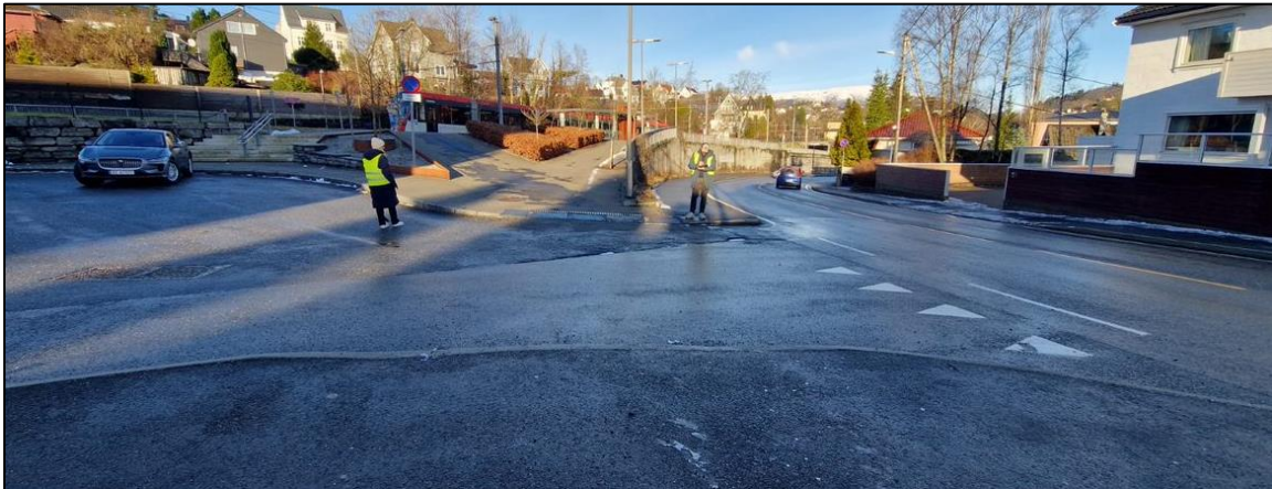
Figur 60 - Krysset ved bybanestoppet i Skjoldskiftet
