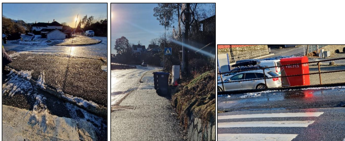
Figur 43 - Manglende nedsenk og ledelinjer, sanering på fortau, oppdelt overgang til gangfelt
