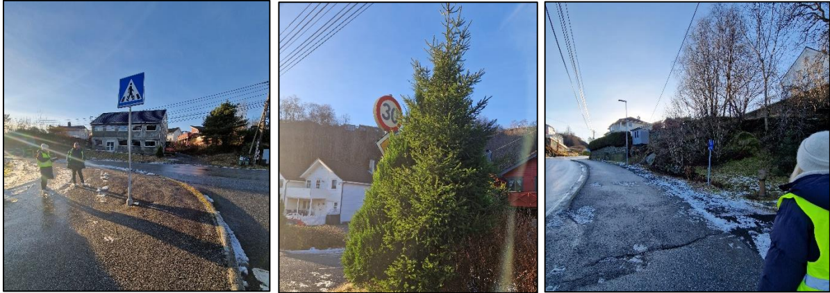
Figur 46 - Skilting for gangfelt plassert i ferdselssone, vegetasjon hindrer sikt til skilting, dårlig plassering av gang- og sykkelvegskilt
