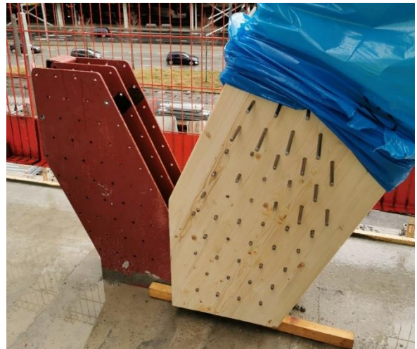
Figur 28: Innspente stålplater brukt på fylkesbygget, Kilde: Sweco
