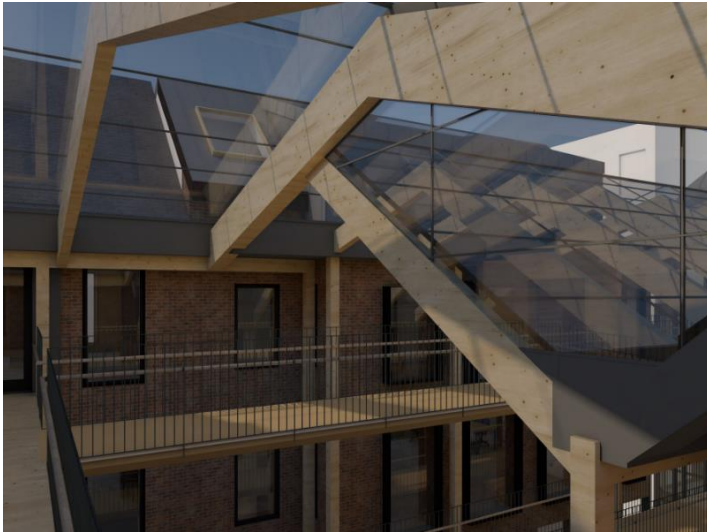
Figur 20: Takbjelkene i atriet fra innsiden. Kilde: Brødrene Ulveseth
