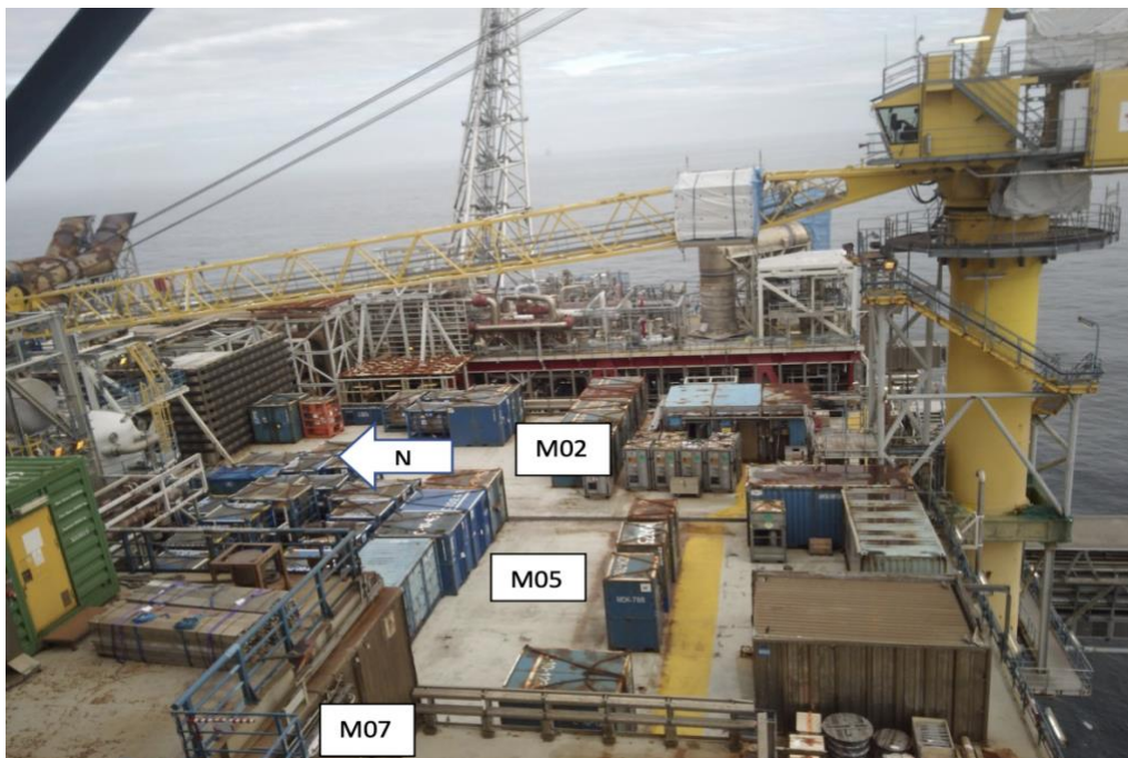
Figur 3: Oversiktsbilde. Elektromodulen skal plasseres på M05.
