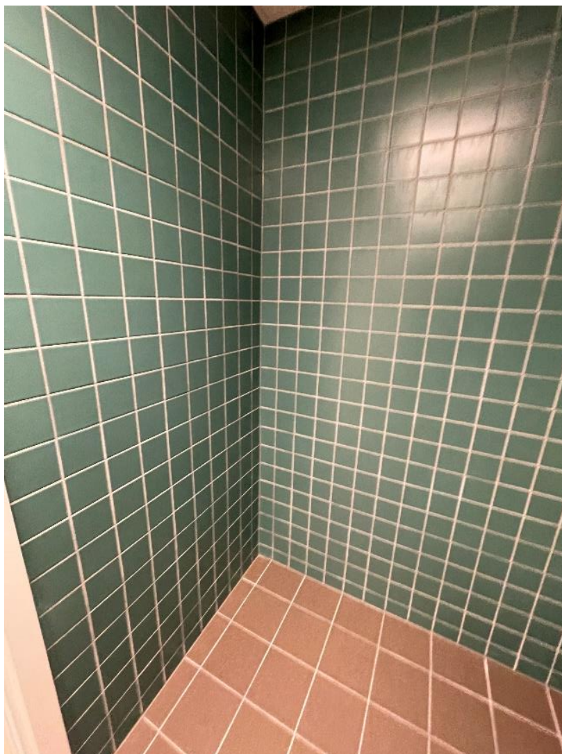
Figur 28: Bilete av bad der flisene er ombruken frå andre prosjekt (Bilde av Henrik Bakke)
