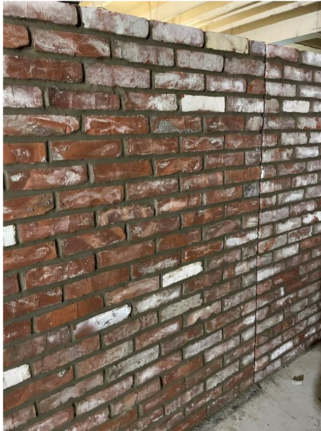
Figur 18: Ombrukt gamal teglstein (Bilde av Henrik Bakke)
