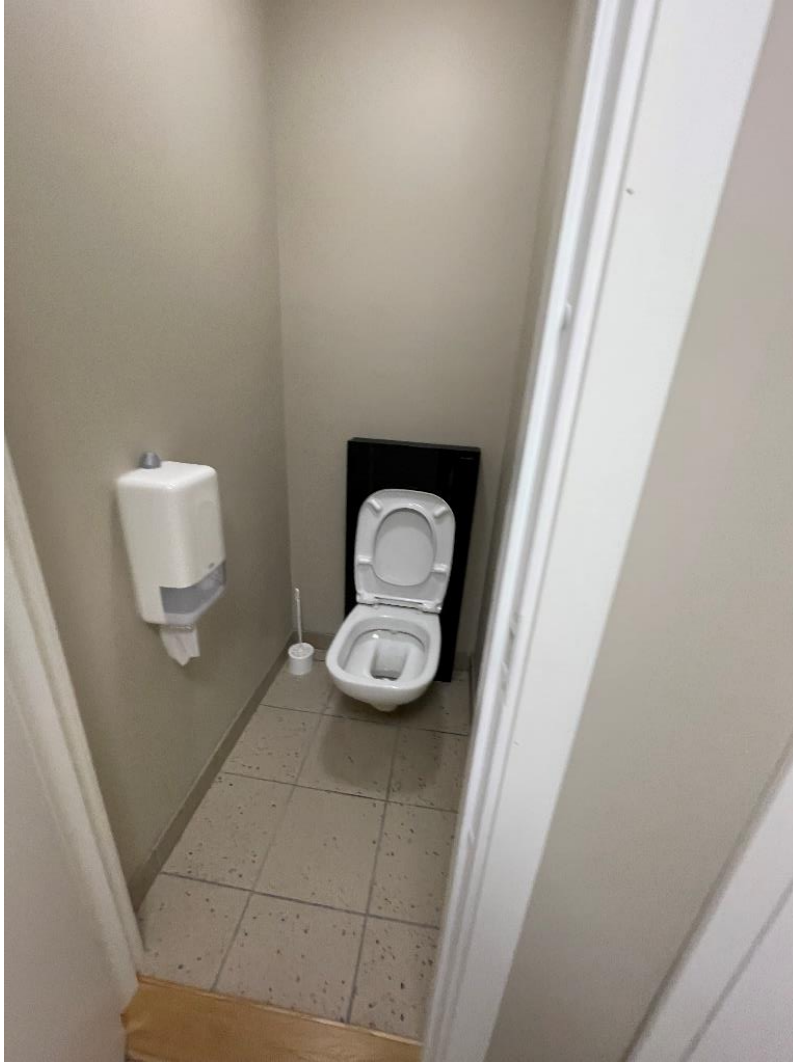
Figur 29: Bilete av bad der flisene er ombruken frå eit anna prosjekt (Bilde Henrik Bakke)
