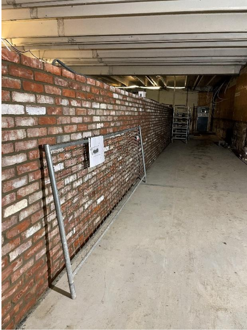
Figur 24: Det vart mykje stein som var brukt om igjen. (Bilde Henrik Bakke)
