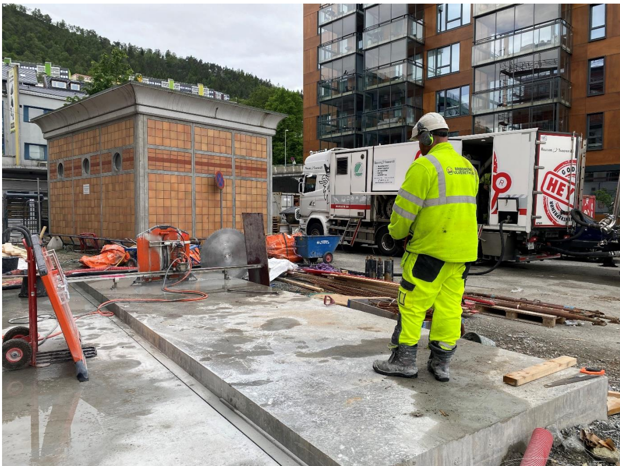
Figur 25: Kranfundamenta vart kuttet opp og løfta på plass der dei skulle brukast om igjen. (Bilde av Brødrene Ulveseth AS)
