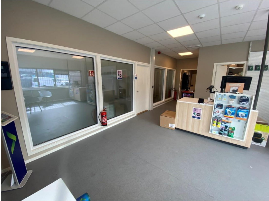
Figur 21: Gjenbrukne vindauge Elkjøp sitt varelager (Bilde frå Brødrene Ulveseth AS)
