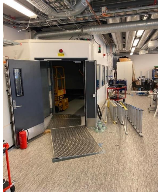
Figure 9 Testrommet sett fra utsiden
