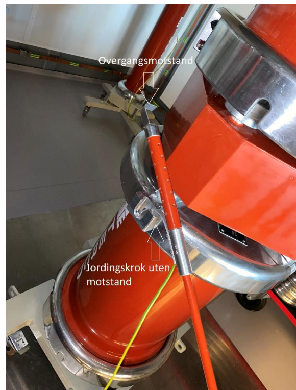
Figur 17 Overgangsmotstand og koblingspunkt direkte mot jord
