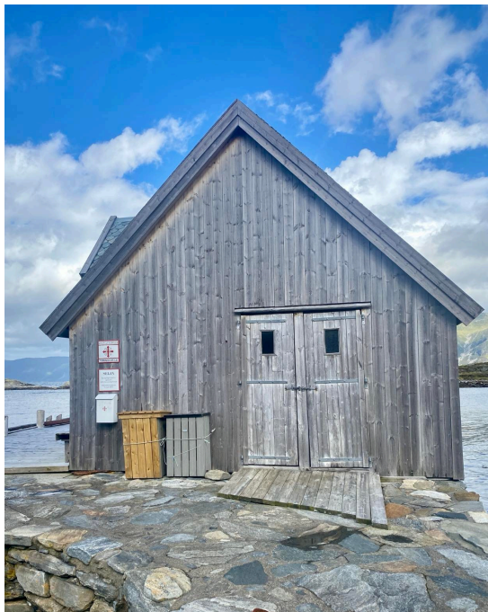
Figur 8: Naustet i Klostervågen. Bildet tatt på synfaring 22.08.2022.
