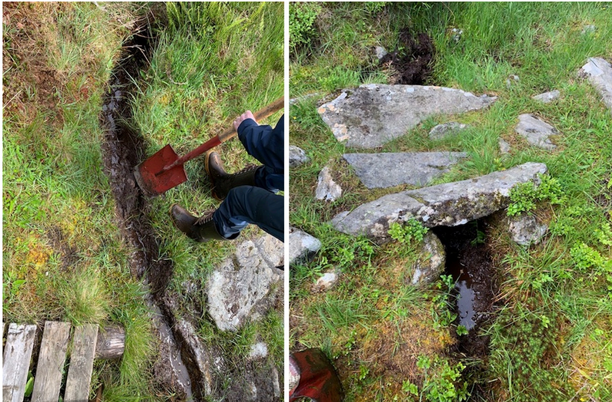
Figur 22: Veiting av steinklopper gjennomført av Stad kommune. Bildet lånt fra Stad kommune.
