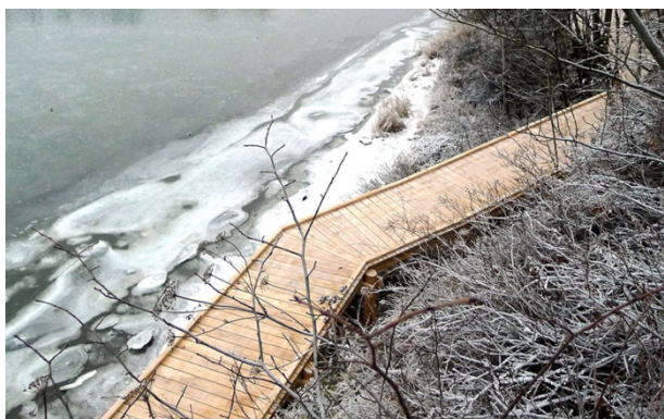
Figur 39 - Bygdøy kyststi (Østengen & Berge AS, u.å).
