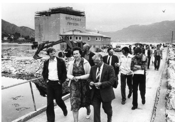
Figur 26 - Åpning av Bremanger Fryseri (Torvanger, 1959).
