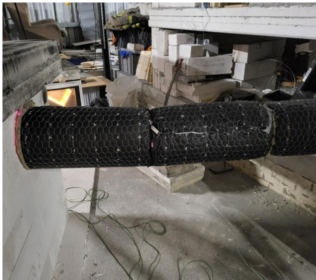
Figur 42: Isolering av kanal med EI 60
