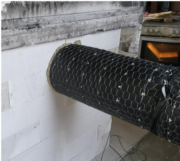
Figur 30: Utførelse av brannisolering på utsiden av brannrom(EI60)
