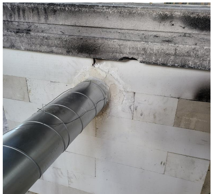
Figur 24: Utsiden av gjennomføring etter branntetting.
