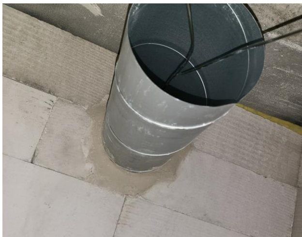
Figur 25: Innside etter branntetting
