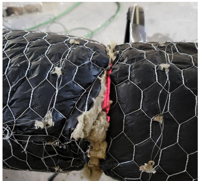
Figur 65: Skjøtt under forsøk
