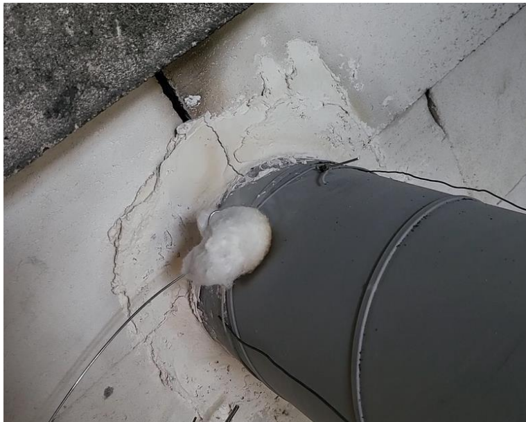
Figur 50: Antennelse av bomulldott etter ca. 10 sekunder
