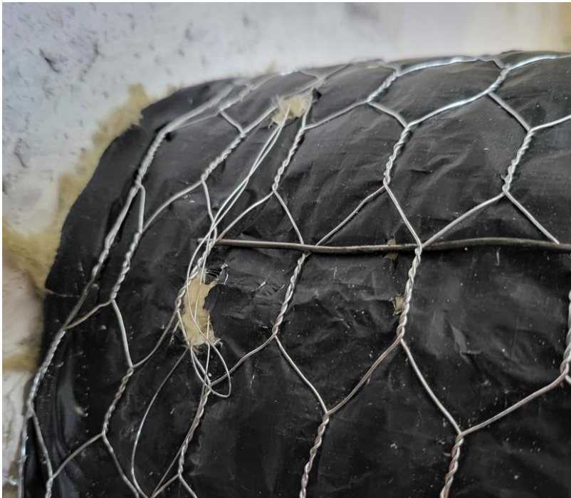
Figur 34: Temperaturmåler plassert oppå brannisolering EI 15.
