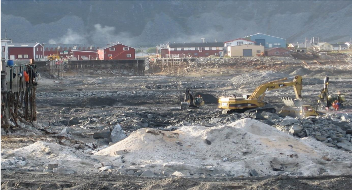
Figur 8 Bilde fra utdypningen i den tørrlagte Sørlandsvågen. Foto: Værøy Kommune
