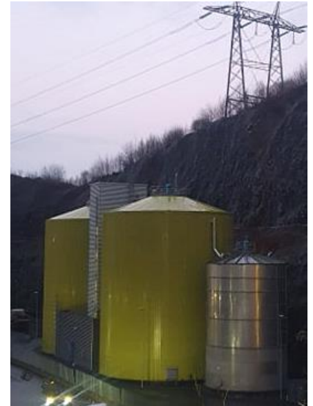
Figur 4: Råtnetankene til biogassanlegget i Rådalen. (privat bilde)
