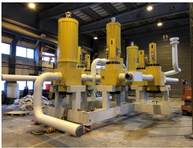
Figur 63 - Subsea installasjon © LMI.
