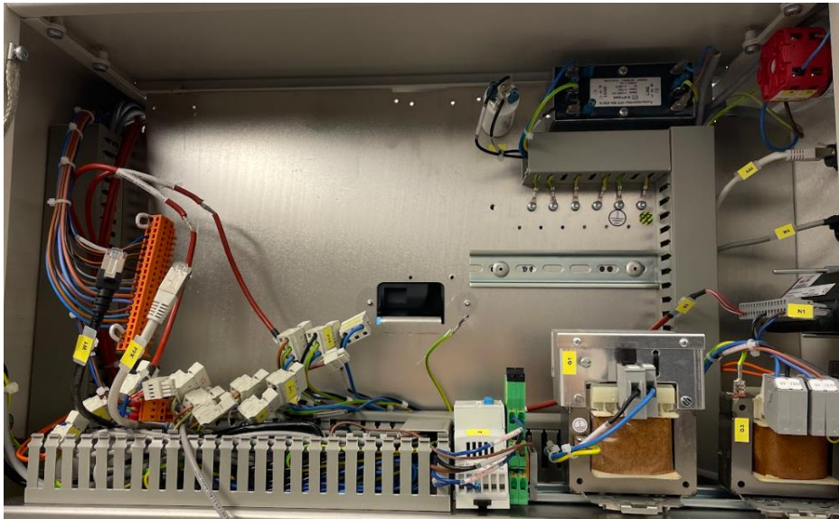
Figur 17 Demontering av eksisterende styresystem
