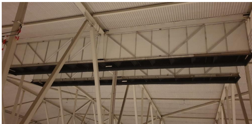
Figur 4 – Røykluker med lyd- og lysfeller
