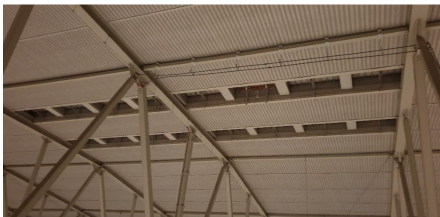
Figur 5 – Røykluker uten lyd- og lysfeller
