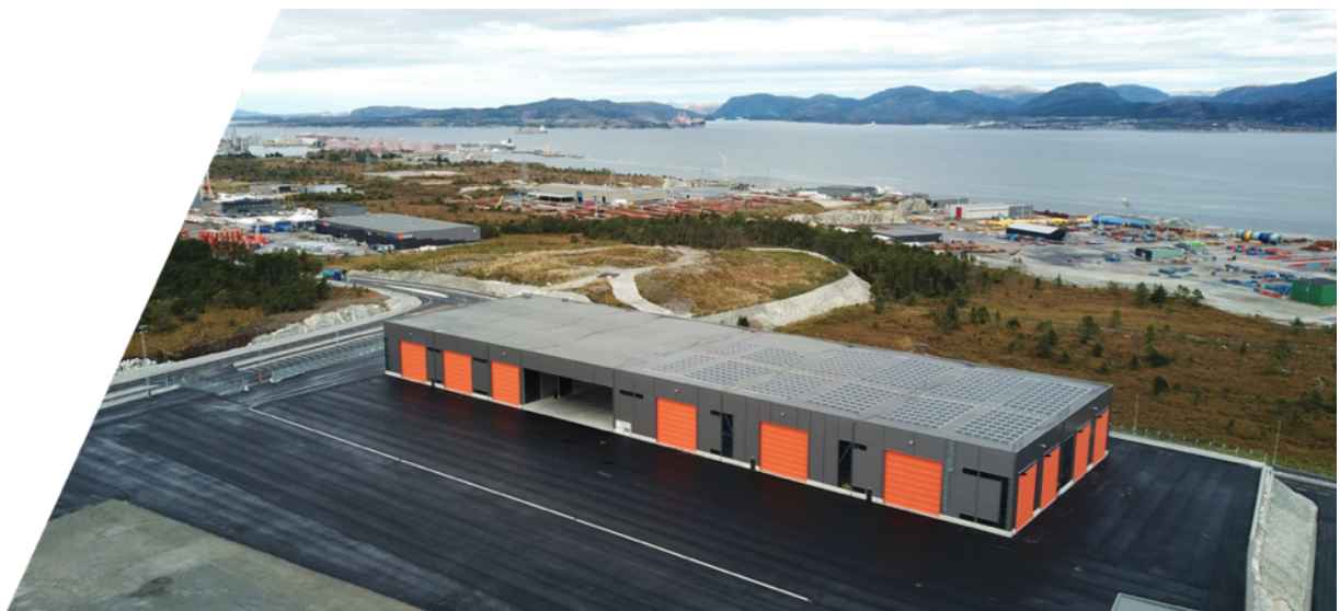
FIGUR 3 - SUBSEAVERKSTEDET MED SOLCELLEANLEGGET, UTSIKT OVER FENSFJORDEN [6]
