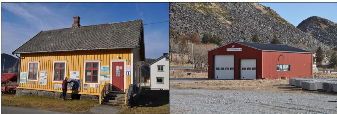
Figur 3.6 Tetthet av innganger. Venstre: Viser hvordan både inngangsdør og vinduer peker ut mot gaten. Høyre: Viser brannstasjon med garasjedører uten inngangsdør.
