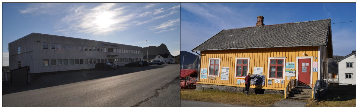
Figur 3.7 100 % Synlighet av innganger for denne vegstrekningen.
