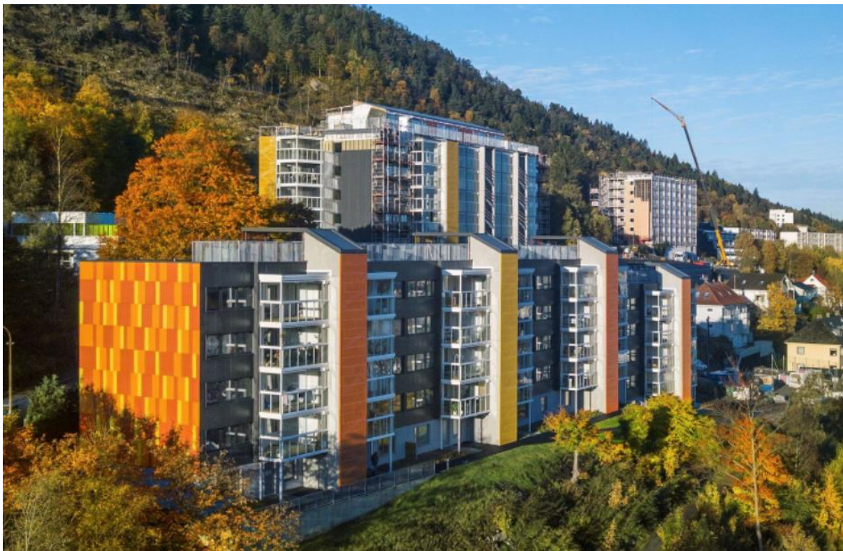
Figur 17: Ferdigstilte lavblokker og høyblokk i bakgrunnen. Kilde: archello.com
