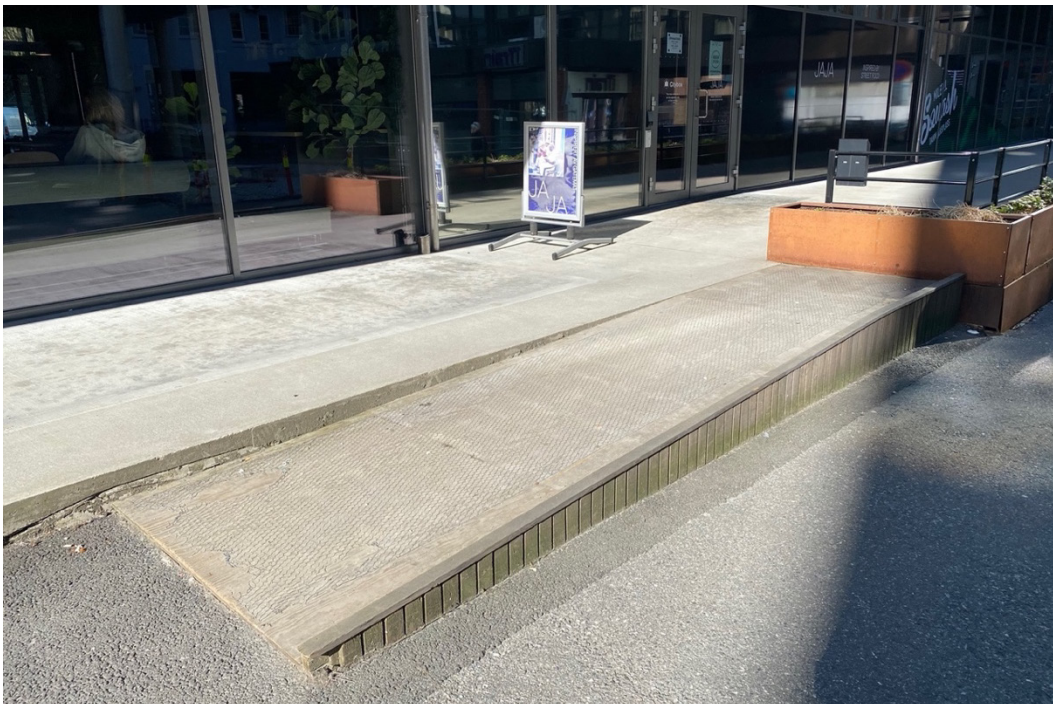
Figur 14: Rampe utenfor JAJA restaurant og Milepæl Squash.
