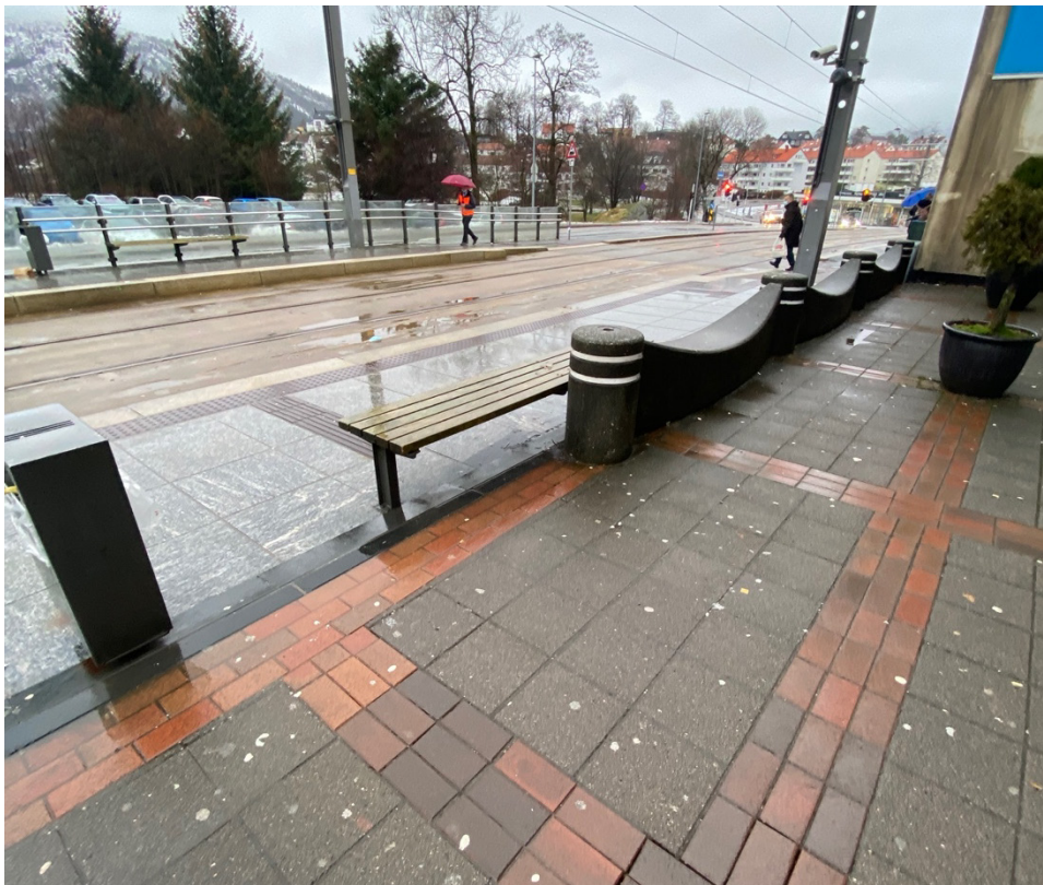
Figur 21: Fysiske barrierer mellom bybanestoppet og torget på Sletten Senter.
