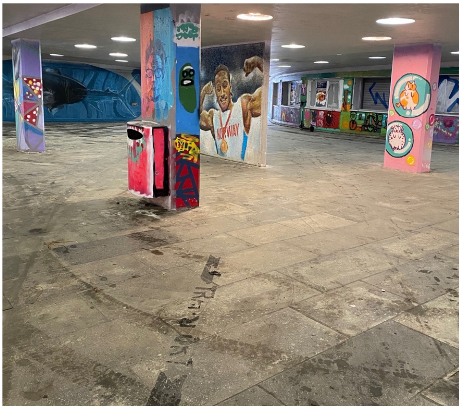
Figur 13: Dekke i undergangen består av store steinheller.
