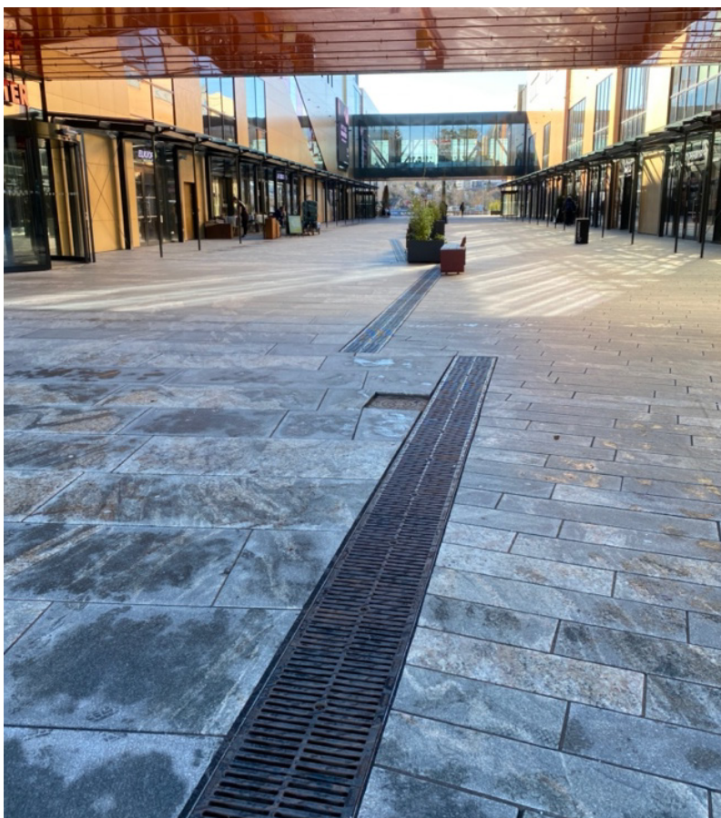
Figur 39: Dreneringsrenne i gågaten
