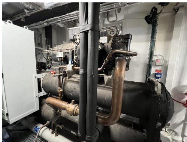
Figur 6: En av varmepumpene levert av Daikin
