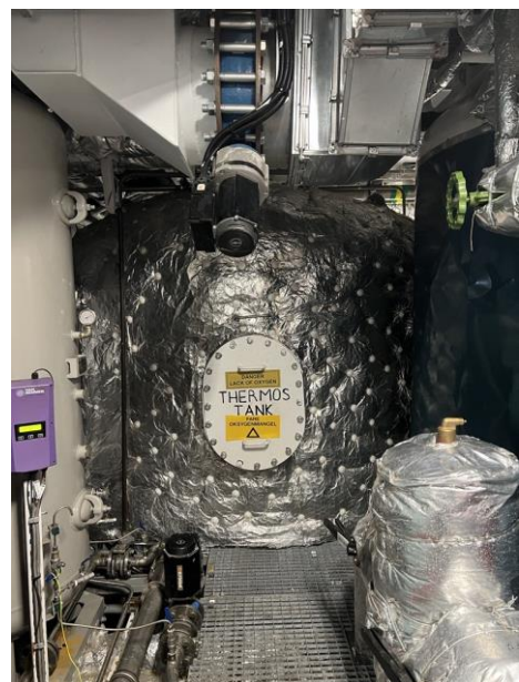
Figur 4: Termostanken om bord på Havila Capella
