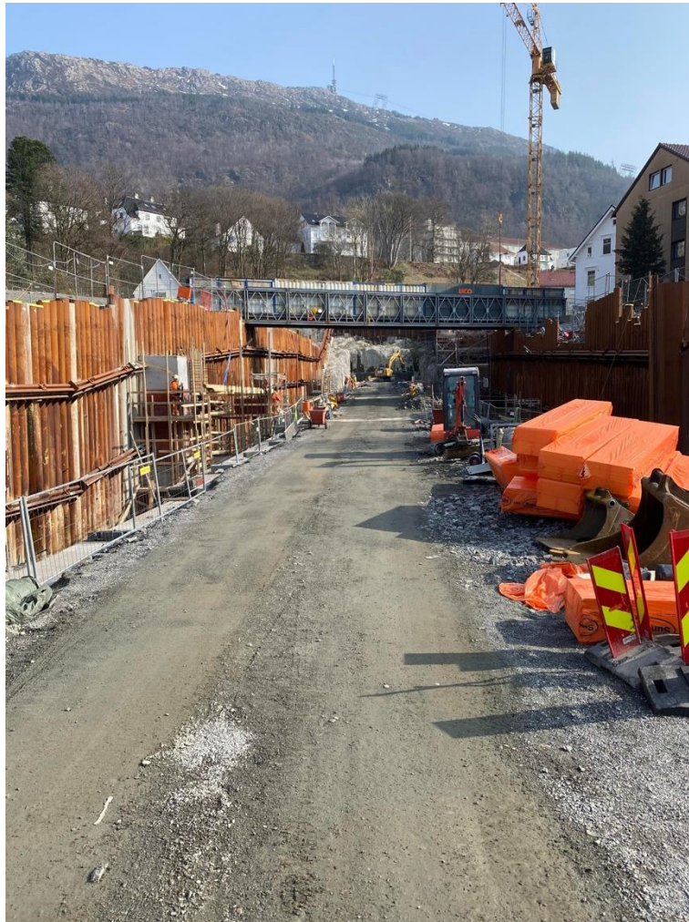
Figur 18 - Bilde langs kulvert, høyde avgrenset med spuntene.
