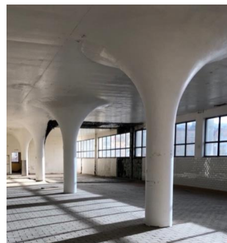
Figur 6: Bilde av søylene med spesiell utforming fra befaringspunktet
