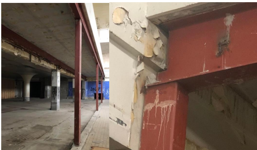
Figur 13: Bilde av mesaninen i første etasje fra befaring
