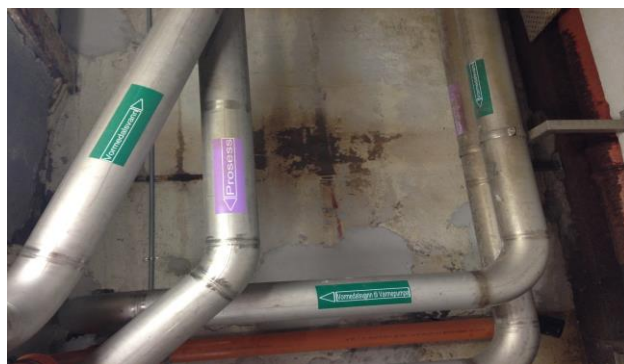
Figur 2: Rør fra FMC Biopolymer som er merket med innhold. Lilla etikett indikerer «prosess», mens grønn etikett henviser til «Vormedalsvann». Fotograf: Heidi B. Olsen
