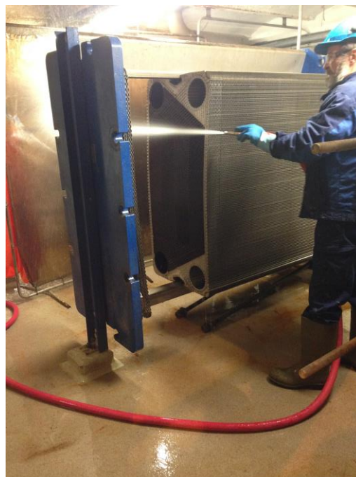
Figur 13: Spyling av plater i en varmevexler. Fotograf: Heidi B. Olsen
