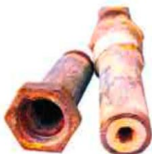
Vannrør før og etter rens
