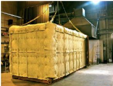
Figur 23 Konteineren kledd i isolasjon.
