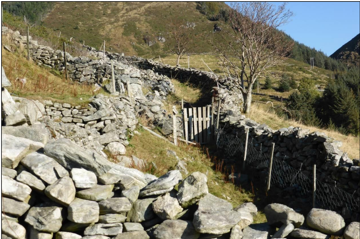
Fig. 22. I overkant av tunet i grenselinjen mellom 49/2 og 49/1, går en burås. Buråsen som er et imponerende stykke steinarbeid er godt vedlikeholdt og svært synlig i terrenget. Foto: Ingvild Austad.
