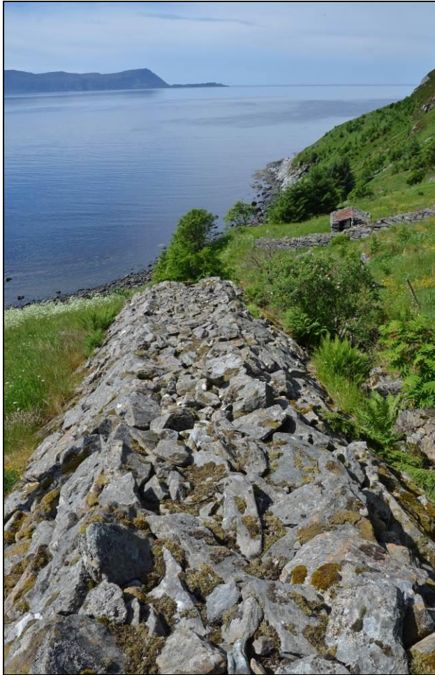
Fig. 43. Det er mange bekker/elver som renner ut i sjøen. I nedbørrrike perioder kan bekkene bli til elver som kan være vanskelige å kontrollere. Flere steder er det derfor bygget opp kraftige vernemurer mot elveløpene (elvetorvbygning). Her fra øvre deler av Kvernhuselva. Foto: Leif Hauge.
