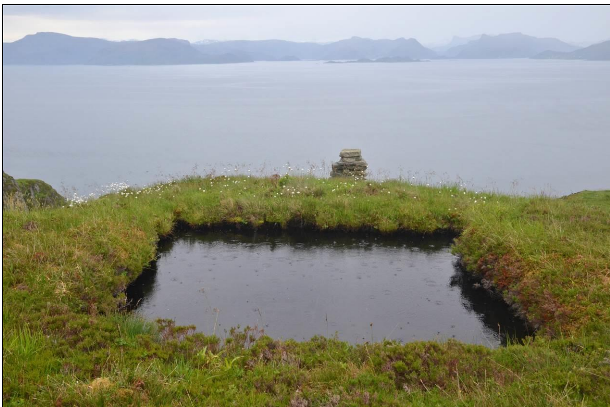
Fig. 78. Isdammen på Ytre Fure med utsikt mot Sildegapet og Vågsøy. Løypestrengfundament ble satt opp på sentrale steder (stup og bratte skrenter) slik at transporten kunne bli så sikker som mulig. Foto: Leif Hauge.
