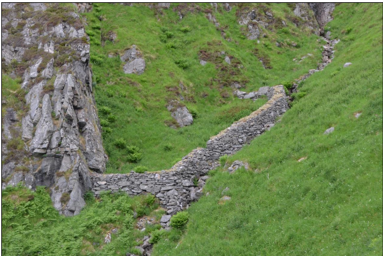
Fig. 65. Det ble ryddet mark og anlagt en liten frukthage på vestsiden av Dale-elva et stykke opp i dalen. Her ble det lagt opp en bakkemur og en kraftig steingard på nedsiden av arealet i 1950-årene. På baksiden hadde man et vanlig gjerde. Dette ble tatt av snøskred og beitedyr (geiter) ødela frukttrærne. Foto: Leif Hauge.
