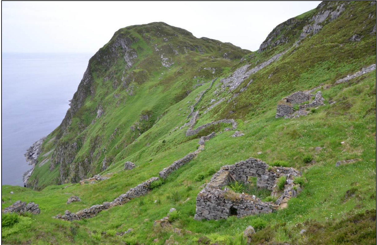
Fig. 64. Lisidene er sterkt preget av steinopplegg, flere steinbygninger og steingjerder. Her ses bøgarden og Torvdalen som ligger i bakkant, fra øst. To av steinfjøsene for kyr i forkant. Foto: Leif Hauge.
