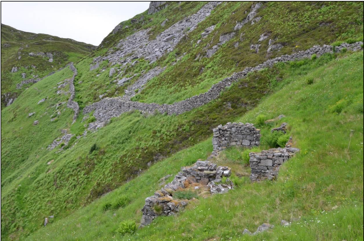
Figur 7. Mye arbeid er lagt ned i de monumentale bøgardene som vi blant annet finner på Ytre Fure (foto), Indre Fure og Ytre Drage. Bøgardene som skiller innmark fra utmark kan være flere hundre meter lange og opptil 2 meter høge. Rydningsstein ble ellers brukt både til grunnmurer, til hele bygninger, til forsterkning av elveløp, som vegfundament og til bakkemurer. Overskuddsstein ble lagt i røyser. Foto: Leif Hauge.
