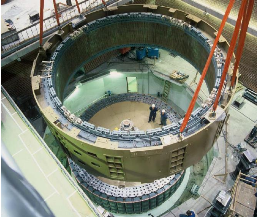
Figur 17 - Stator som senkes ned [12]
