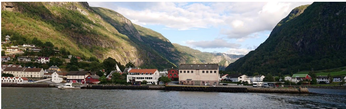
Figure 5: The existing building (in beige) seen from the fjord. Source: (Nærøyfjorden Verdensarvpark & Aurland Kjøle- og Fruktlager SA, 2020)
